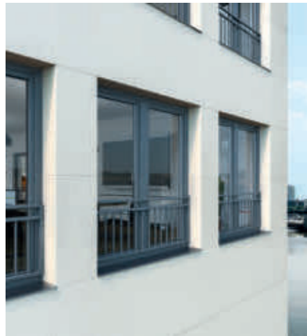
Mit der neuen Absturzsicherung mit vertikalen Stangen bietet Schüco jetzt vier geprüfte Versionen.
