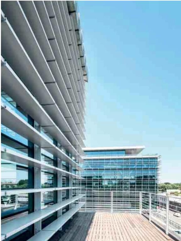
Vertikal und horizontal einbaubar, in starrer und beweglicher Ausführung – das flexibel planbare Sonnenschutzsystem bietet zahlreiche Möglichkeiten für eine attraktive Fassadengestaltung.
