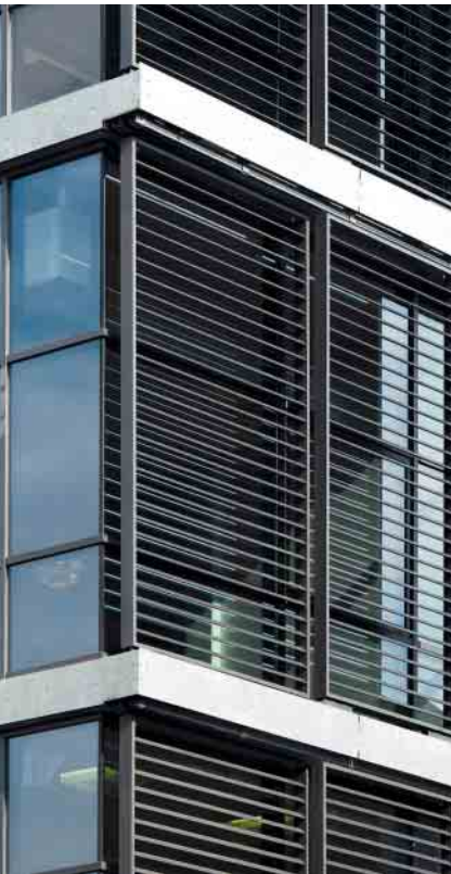
Schüco Schiebeladen ALB 105 SH Schüco Sliding Shutters ALB 105 SH
