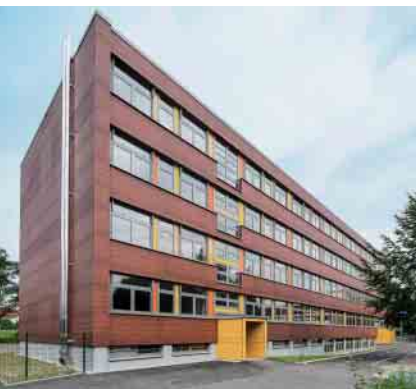
Optisch ansprechend und energetisch überzeugend: die Südostfassade der Grundschule Sachsenallee, ausgestattet mit Schüco TipTronic Oberlichtern Visually attractive and impressive in terms of energy efficiency: the south-east façade of Sachsenallee primary school fitted with Schüco TipTronic toplights
